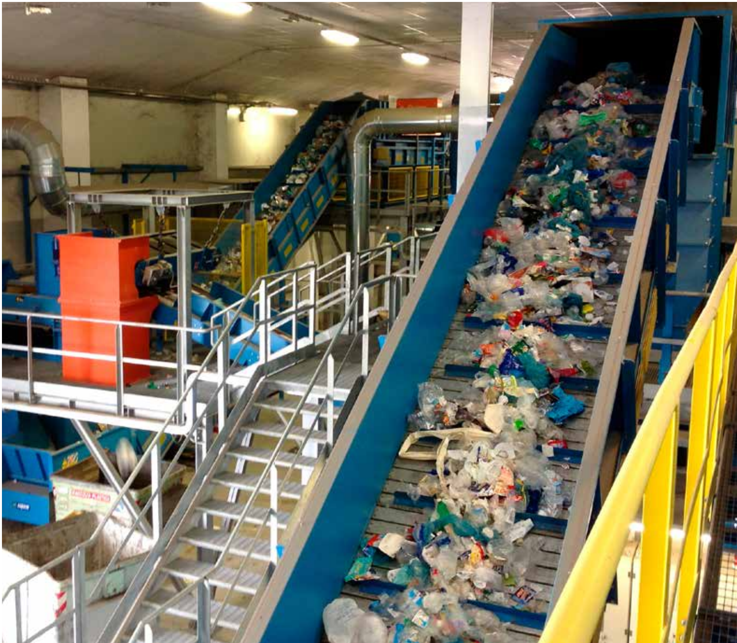
Linea di selezione multimateriale 6 ton/h - Multimaterial sorting line 6 ton/h
