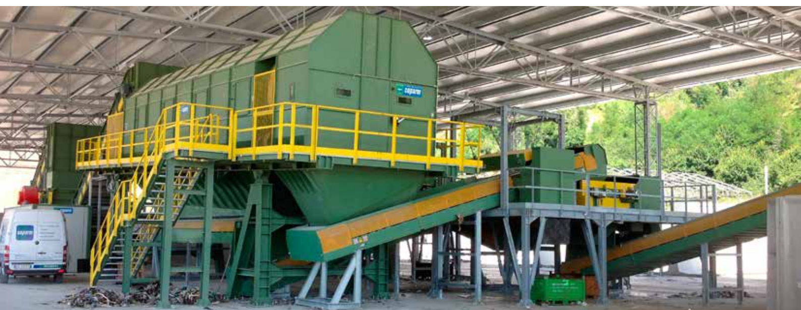
Impianto di trattamento RSU 50-60 ton/h - MSW treatment plant 50-60 ton/h
