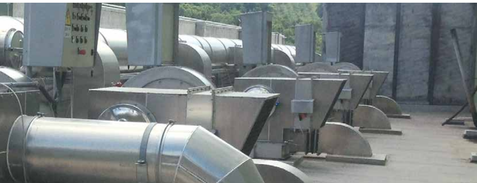
Impianto di biostabilizzazione rifiuti RSU - MSW waste biostabilization plant
