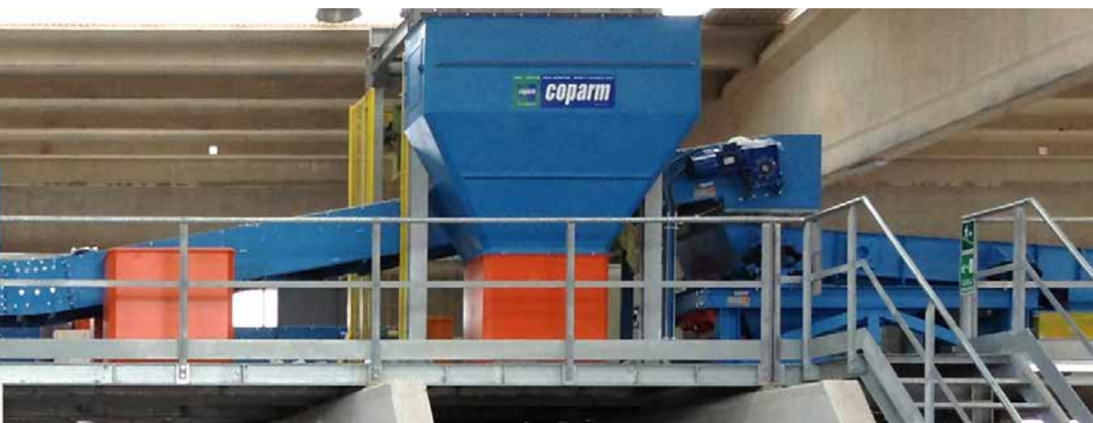
Linea di selezione multimateriale - Multimaterial sorting line
