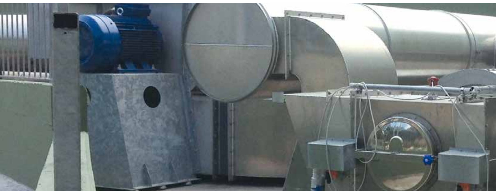
Impianto di produzione CSS separatore aeraulico CDR production plant aeraulic separator
