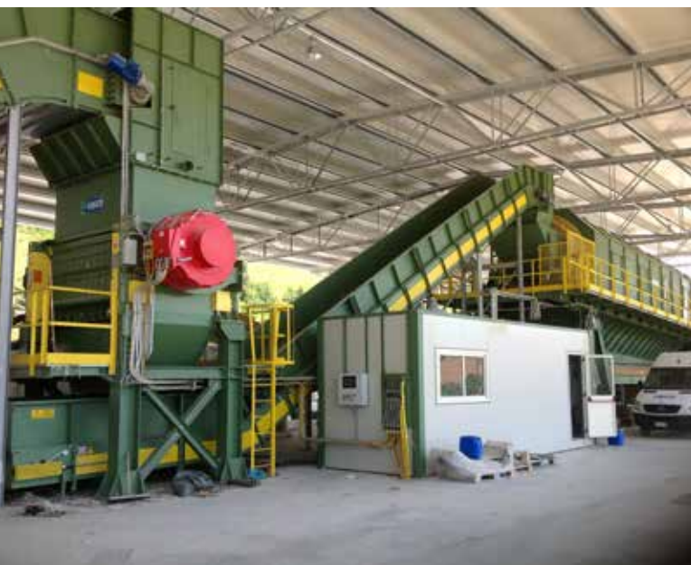
Linea di selezione RSU 60 ton/h - MSW sorting line 60 ton/h
