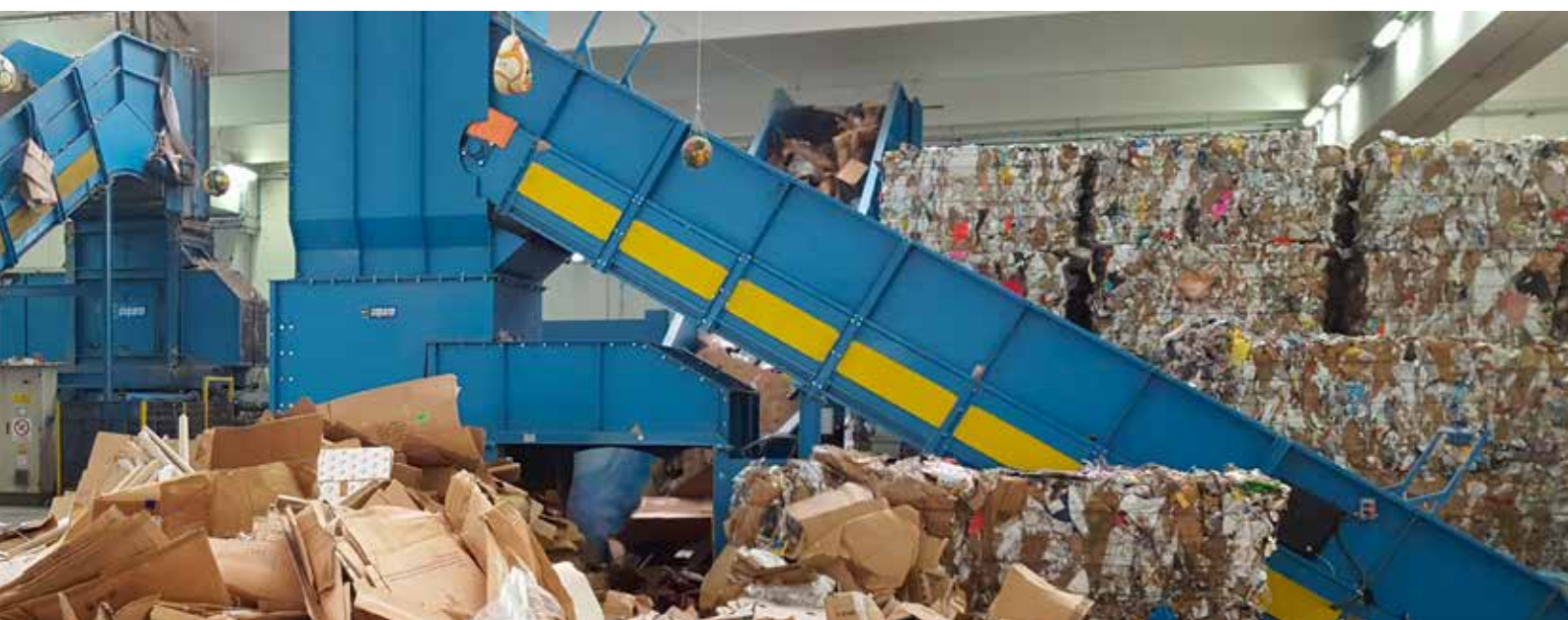
Impianto di triturazione e imballaggio carta da macero - Waste paper shredding and baling plant
